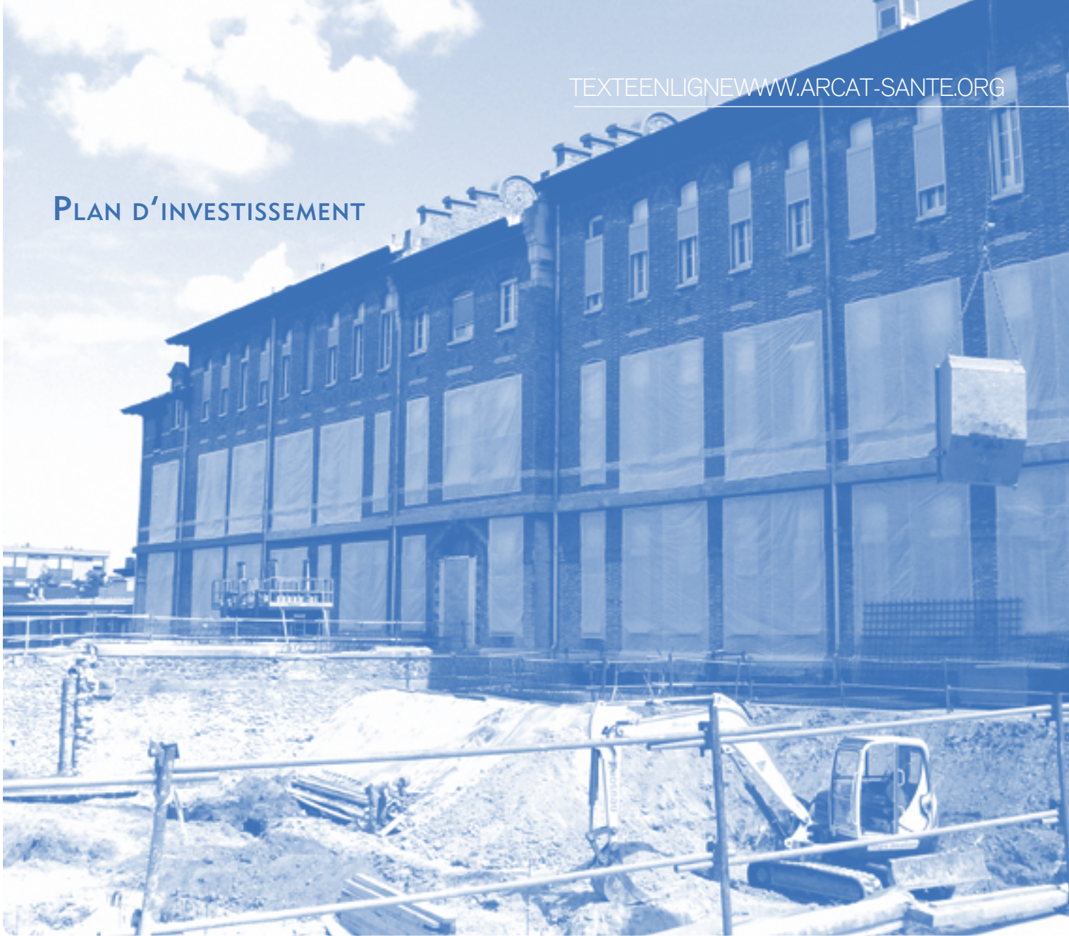
Photo : Marianne Langlet (travaux à l'Hôpital Pitavet Suppénière de Paris).
